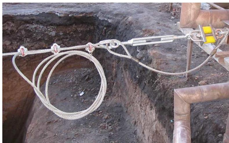
Fijado el sistema, se tensará el cable manualmente mediante el tensor, tomando como referencia la separación de tensado la separación de 3 mm entre el cáncamo del absorbedor y la placa metálica de éste.
