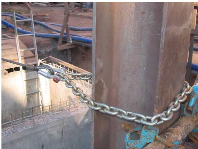
Instalada la LVH en un extremo se procede a montar el extremo restante del dispositivo. Se coloca la cadena a la estructura y se une la misma con el cáncamo del absorbedor de energía, mediante el grillete. Considerar recomendación de colocación de grillete indicada en párrafos anteriores. Al momento de unir estos dos elementos, incorporar un ojo de la eslinga de seguridad.
