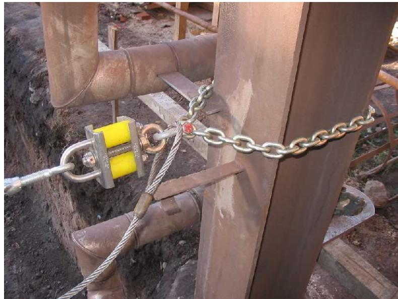
Sobre el cáncamo opuesto del absorbedor de energía se encuentra vinculado un ojo del tensor. Por el extremo restante de este último, y por el segundo ojo de la eslinga de seguridad, se pasa el cable de acero, el cual se fija con tres prensacables como mínimo. Como protección del cable de acero se coloca un guardacabo.
